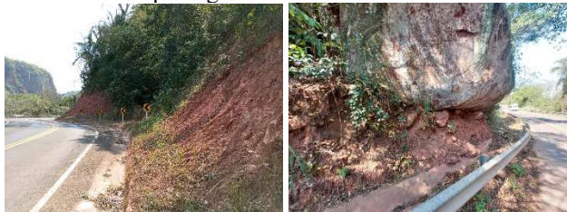
Figura 02 - Processo erosivo às margens da Rodovia MS-450, Distrito de Piraputanga-MS.
